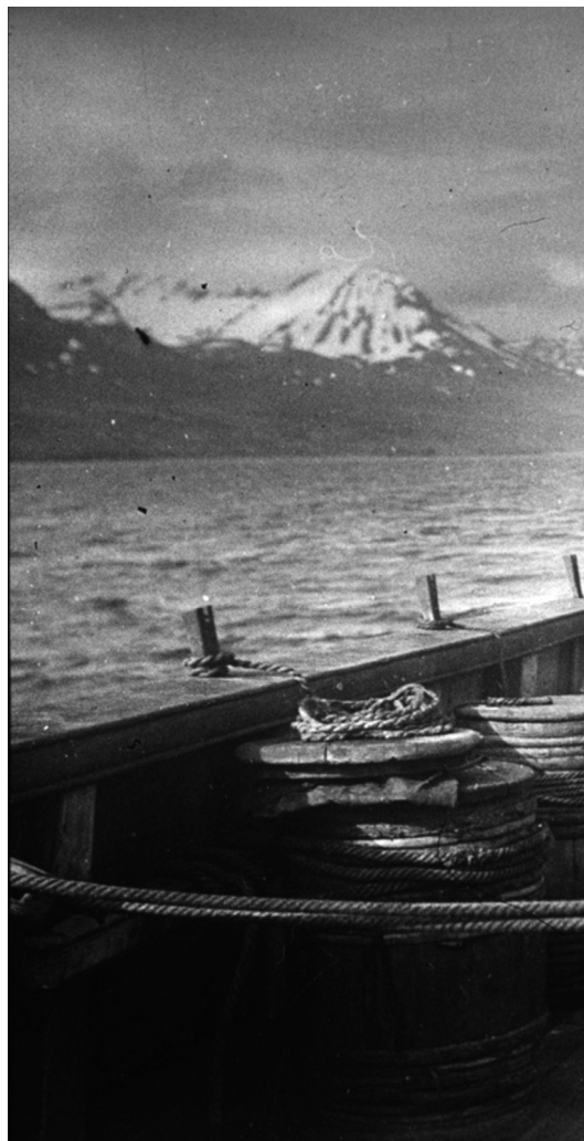
Het werkterrein van de kolder: de reling aan loefzijde, de lange lijn vierend. Die kollijn lag in de gleuf van de kolkklamp (mikke). Op de reling bemerk je drie van die mikken.
